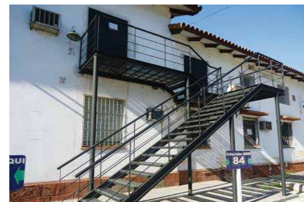
Nuevo acceso a la Biblioteca
