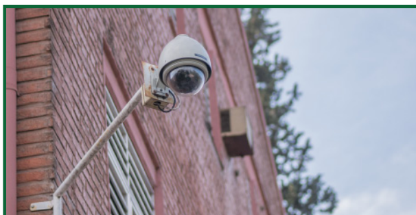
Mantenimiento cámaras de seguridad.
