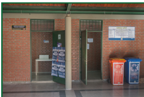
Remodelación de vestuarios.
